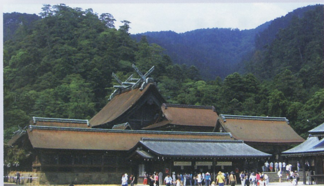
お屋根葺き替え前の豪壮な出雲大社本殿
