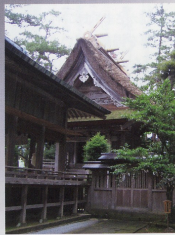
「隠岐造り」の本殿は風格を供えている 隠岐国一の宮 水若酢神社
