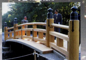
架け替えられたばかりの火除橋
