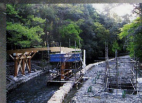
架け替え中の風日折宮橋
