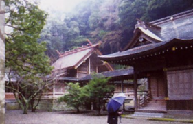
葺き替えが済み未だ新しい屋根の拝殿
