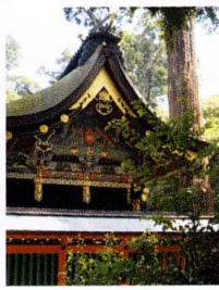
鹿島神宮本殿
